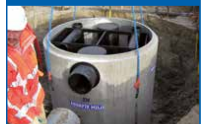
Afwatering bedrijfsterrein Kloosterzande
