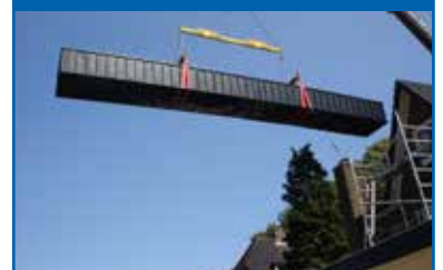
Regenwaterbuffer woonhuis Soest
