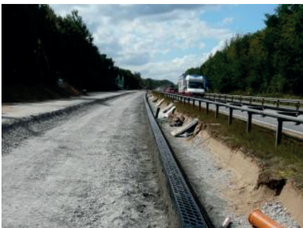
HYDROblock, Project: Autobaan A24, Hamburg - Berlijn
