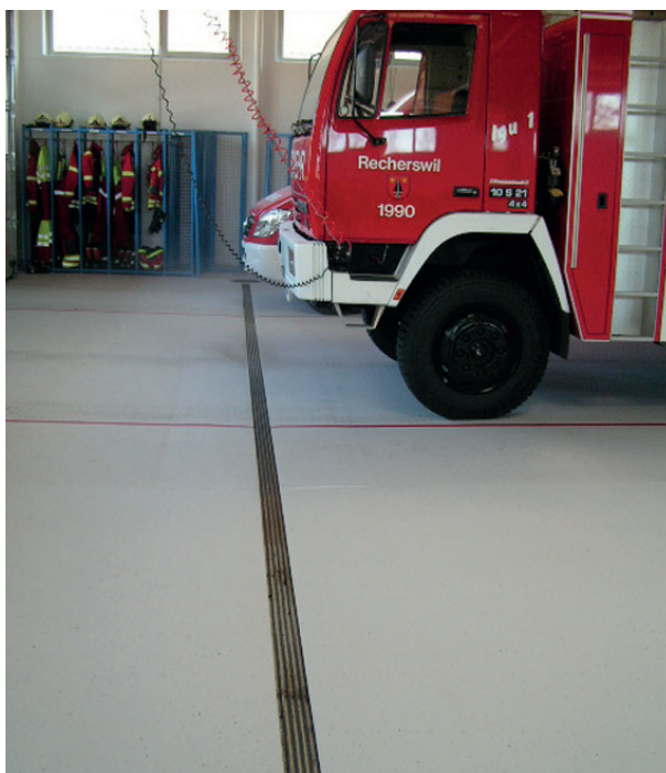
HYDROline Project: Brandweerhal, Zwitserland
