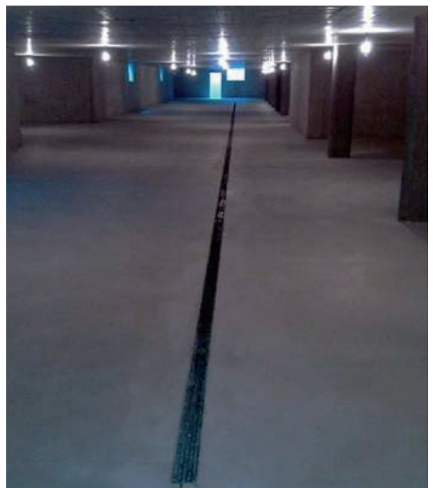
HYDROline Project: Ondergrondse parkeergarage, Zwitserland
